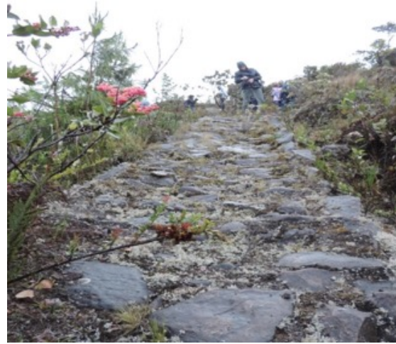
Figura. Calzada empedrada y bien conservada de un metro de ancho
