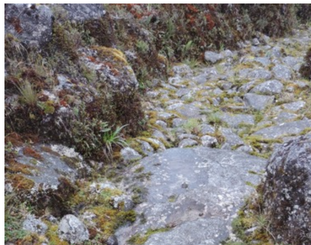
Adaptación del afloramiento de roca natural con piedras transportadas para la calzada
