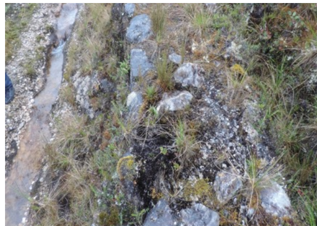
Camino de un metro de ancho y canal lateral
