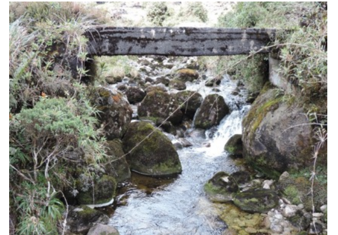
Puente actual de hormigón armado edificado sobre pedestales antiguos
