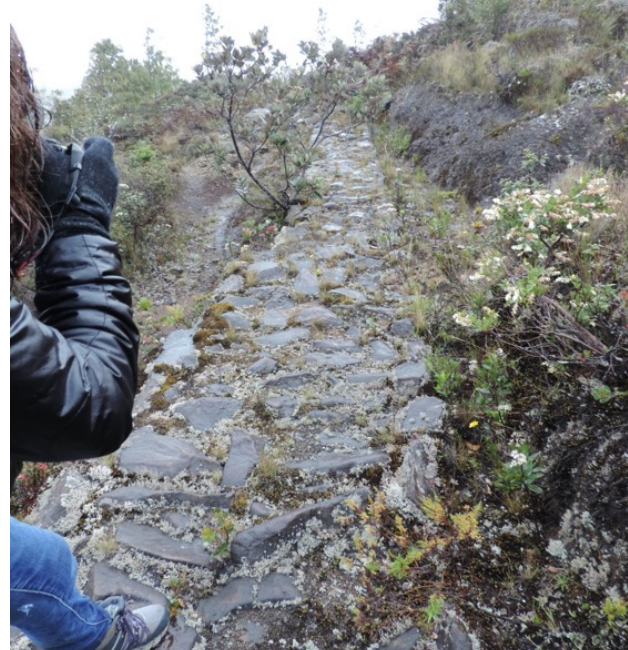
Figura. Camino empedrado con un corte de talud de roca y canal lateral
