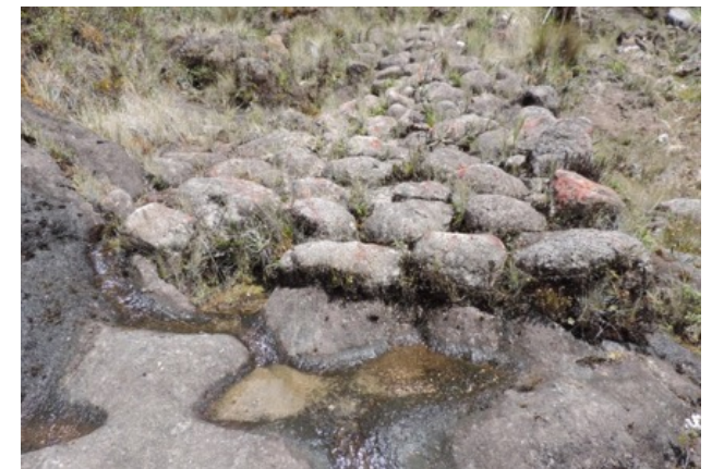
Figura. Perspectiva de la técnica de construcción del empedrado cimentado sobre cunetas excavados en el afloramiento rocoso
