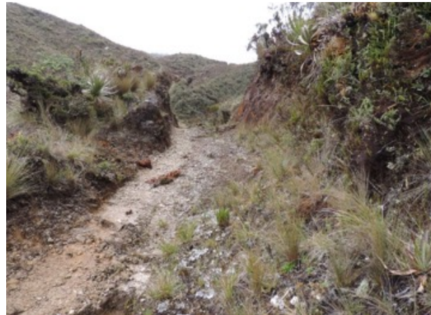
Camino excavado en roca natural y protegido por cortes de talud lateral
