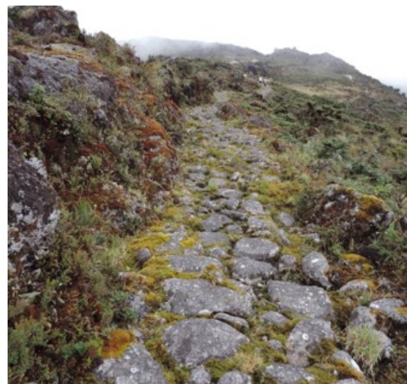
Camino de 2 metros de ancho protegido de hileras de piedra y taludes
