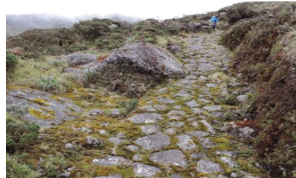
Piedras planchas transportadas y acomodadas conforman el empedrado del camino y talud lateral
