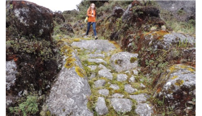
Empedrado ergonómico diseñado con hileras de piedra para la protección del camino y caminante
