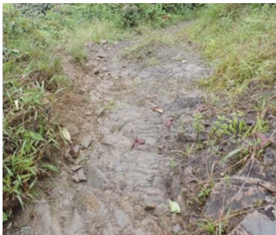
Segmento del camino trazado sobre afloramiento rocoso más de tres metros de alto
